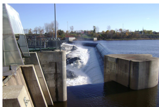
Visite centrale hydroélectrique d'Innergex Source : COBARIC
