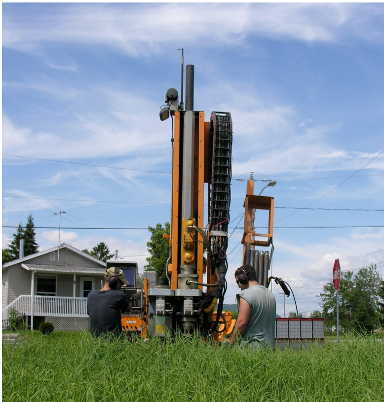
Forage dans les dépôts meubles et au roc (INRS, 2013)
