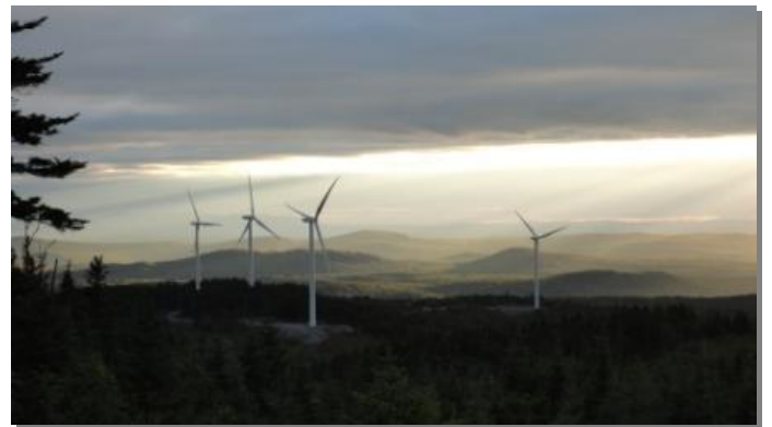
Éoliennes du Parc éolien de Saint-Robert-Bellarmin (Photo : Municipalité de Saint-Robert-Bellarmin)
