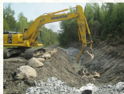
Aménagement de l'avaloir © COBARIC, 2015
