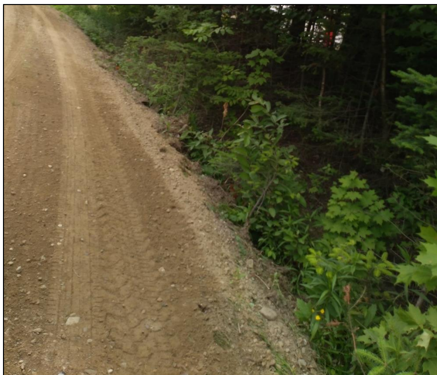
Figure 19. Exemple d'un chemin avec un mauvais entretien de la végétation du fossé, où il y a présence d'essences ligneuses, mais quasiment aucune herbacée
