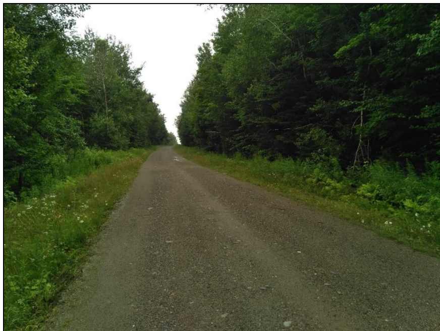
Figure 18. Exemple d'un chemin parfaitement conçu, avec des bords de chemin et des fossés végétalisés (bassin versant de la rivière Clinton)
