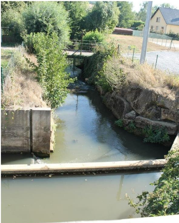
Figure 39. La jonction à 90 degrés du cours d'eau
