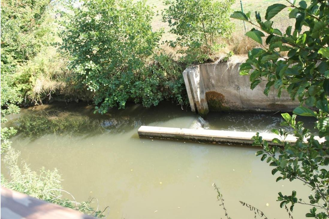
Figure 38. Aménagement permettant de ralentir le débit du cours d'eau avant son entrée dans un tournant à 90 degrés
