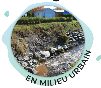
Modification du lit et problématique de stabilité à Tring-Jonction, 2020.
